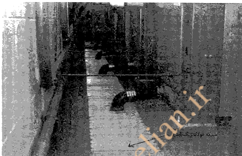
شکل (۳۵-۵-۱۶) کانال تخلیه ماشین‌های لباس‌شوئی در رختشوی‌خانه عمومی
