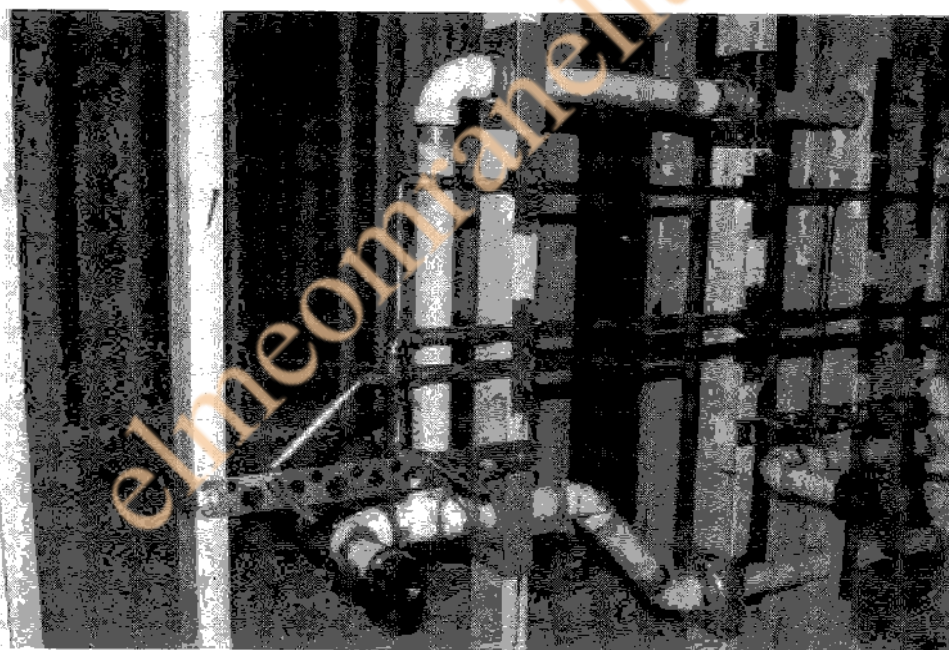
شکل (۹-۱۶-۱۴) بست‌های لوله‌های مسی افقی در محل اتصال به لوازم بهداشتی
