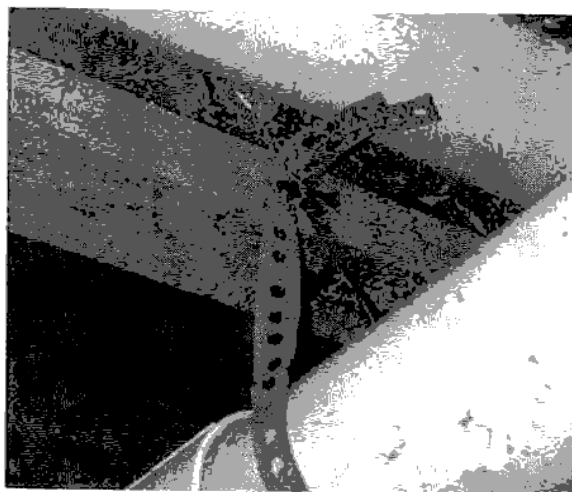
شکل (۱۶-۹-۲) بست آویز نامناسب از تسمه فلزی با اتصال ضعیف به تیر چوبی
