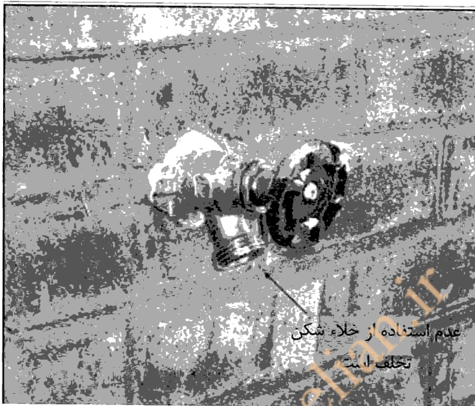
شکل (۱۶-۴-۴۰) شیر آب سرشلنگی بدون خلاء شکن
