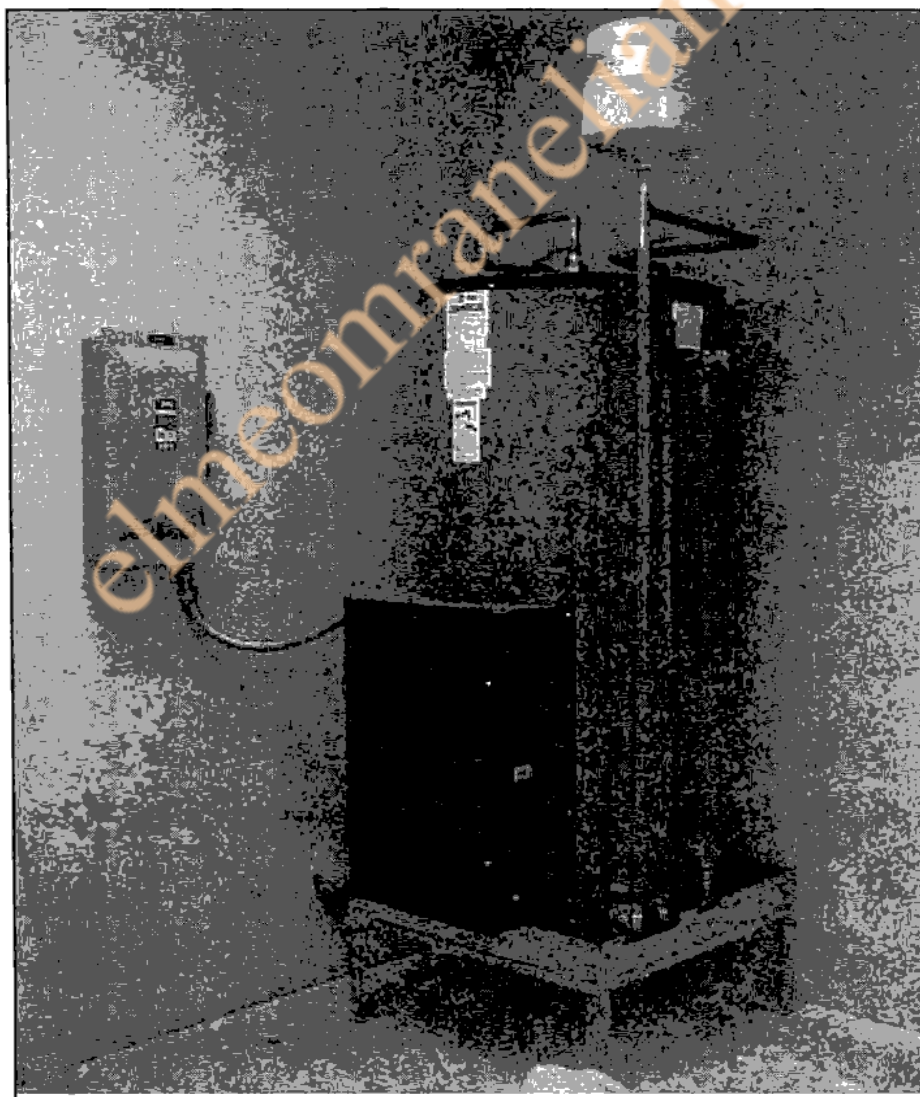
شکل (۴-۱۶-۵۹) قطع کن الکتریکی در مجاورت آب گرم کن
