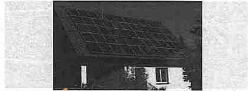
شکل ۸۷ ترکیب مدول های فتوولتائیک با بام شیبدار
