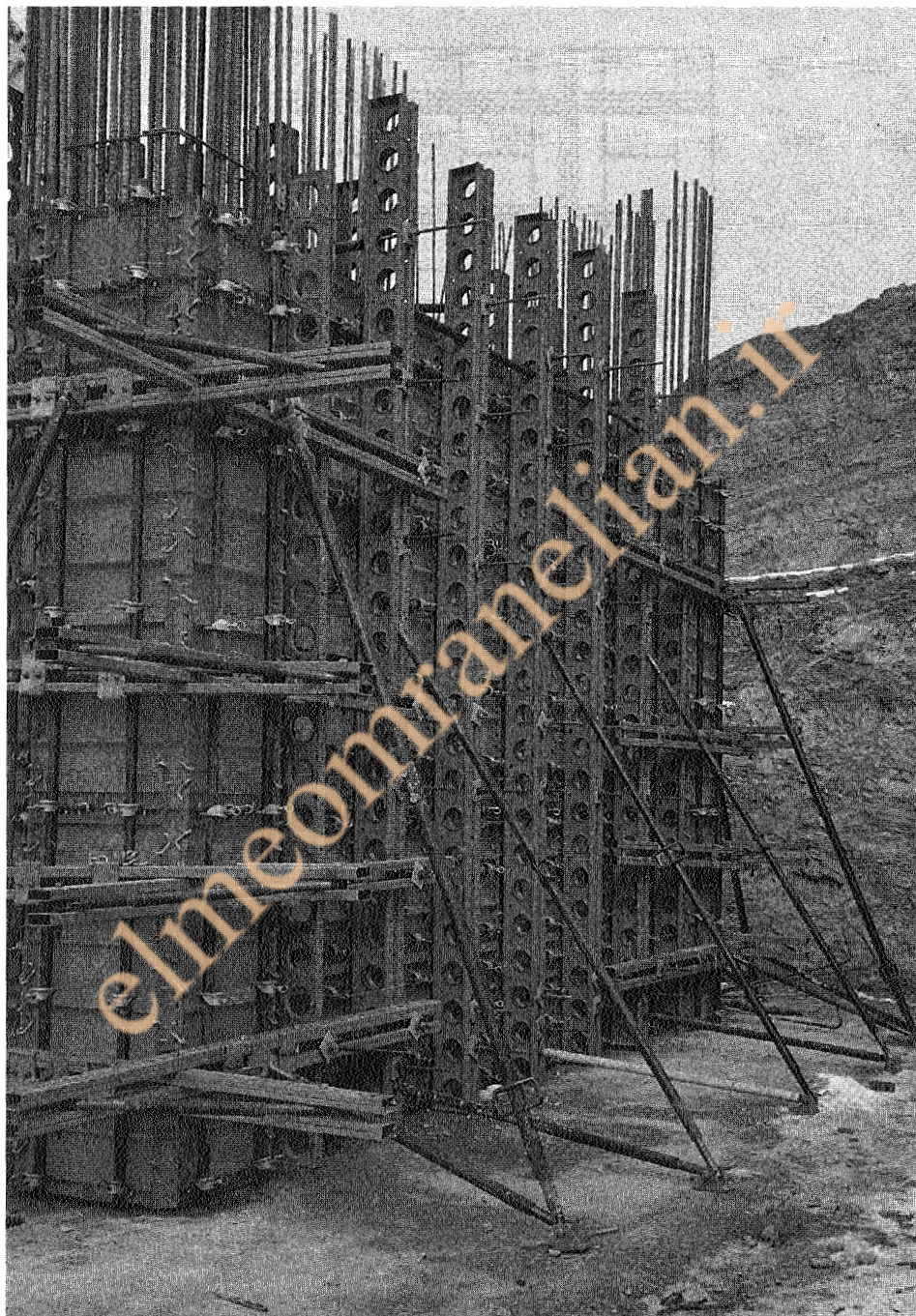
شکل ۶-۶ قالب دیوار مونتاژ شده از قالب‌های پانلی.
