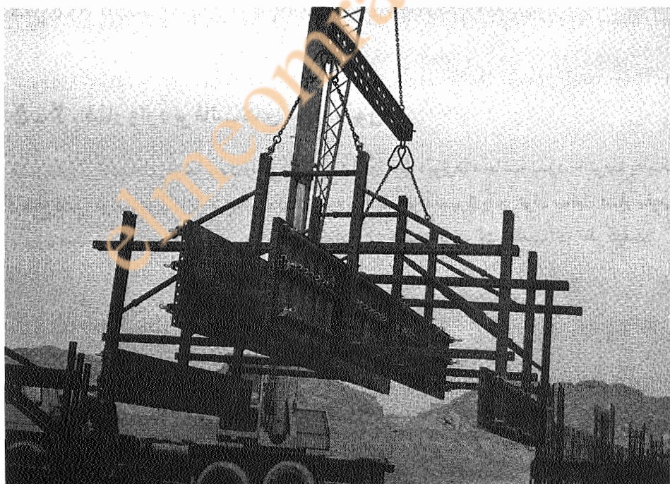
شکل ۵-۸ قالب‌های فلزی فونداسیون.
