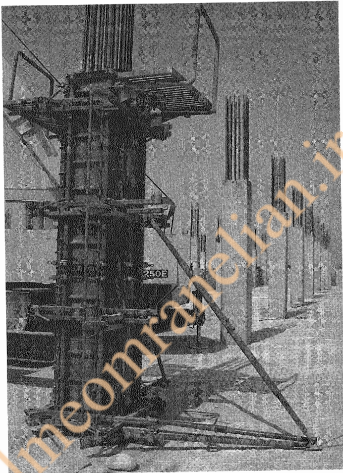
شکل ۷-۳ قالب ستون یکپارچه فلزی با جک تنظیم و جک شاغولی و سکوی بتن‌ریزی.
