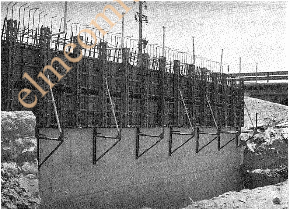
شکل ۸-۶ قالب دیوار ساخته شده از قالب‌های پانلی.
