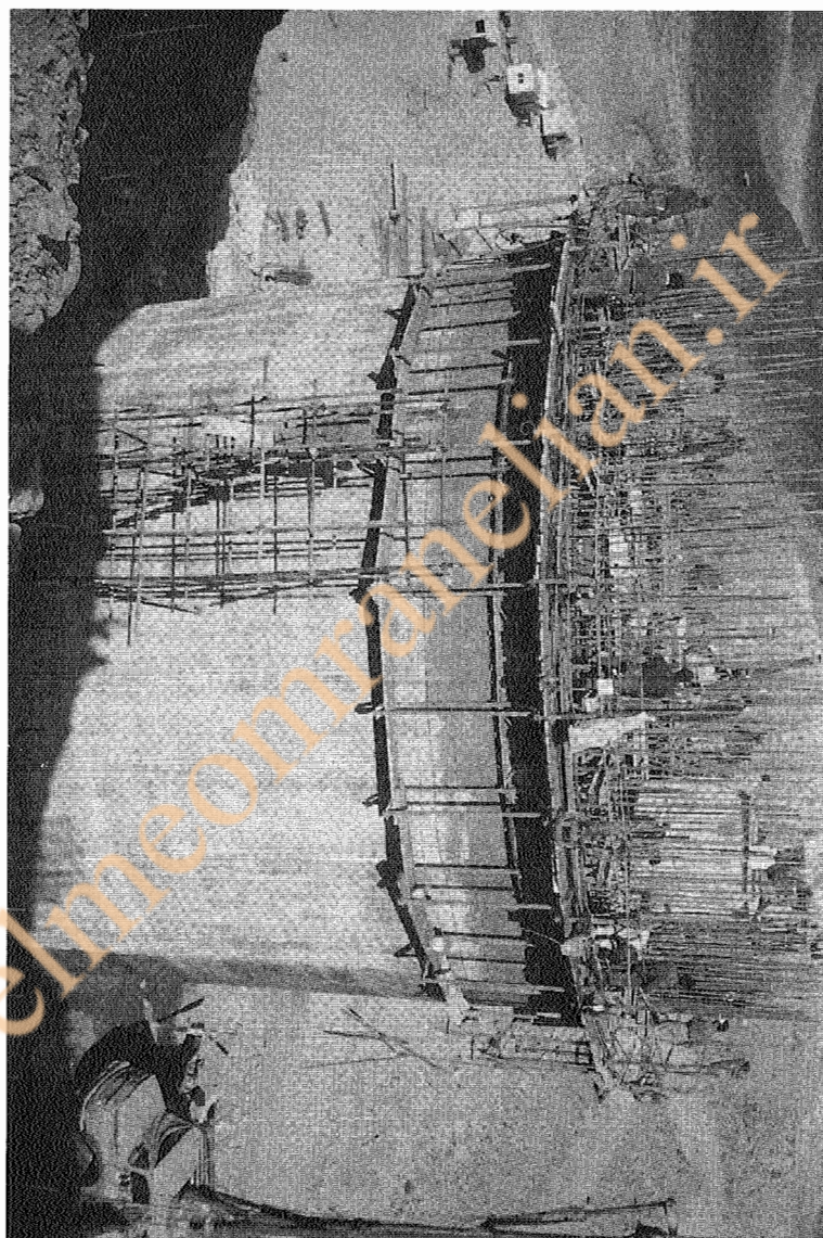
شکل ۱۰ - ۲ (ادامه) - قالب لغزنده و سکوی پرداخت سطحی.
