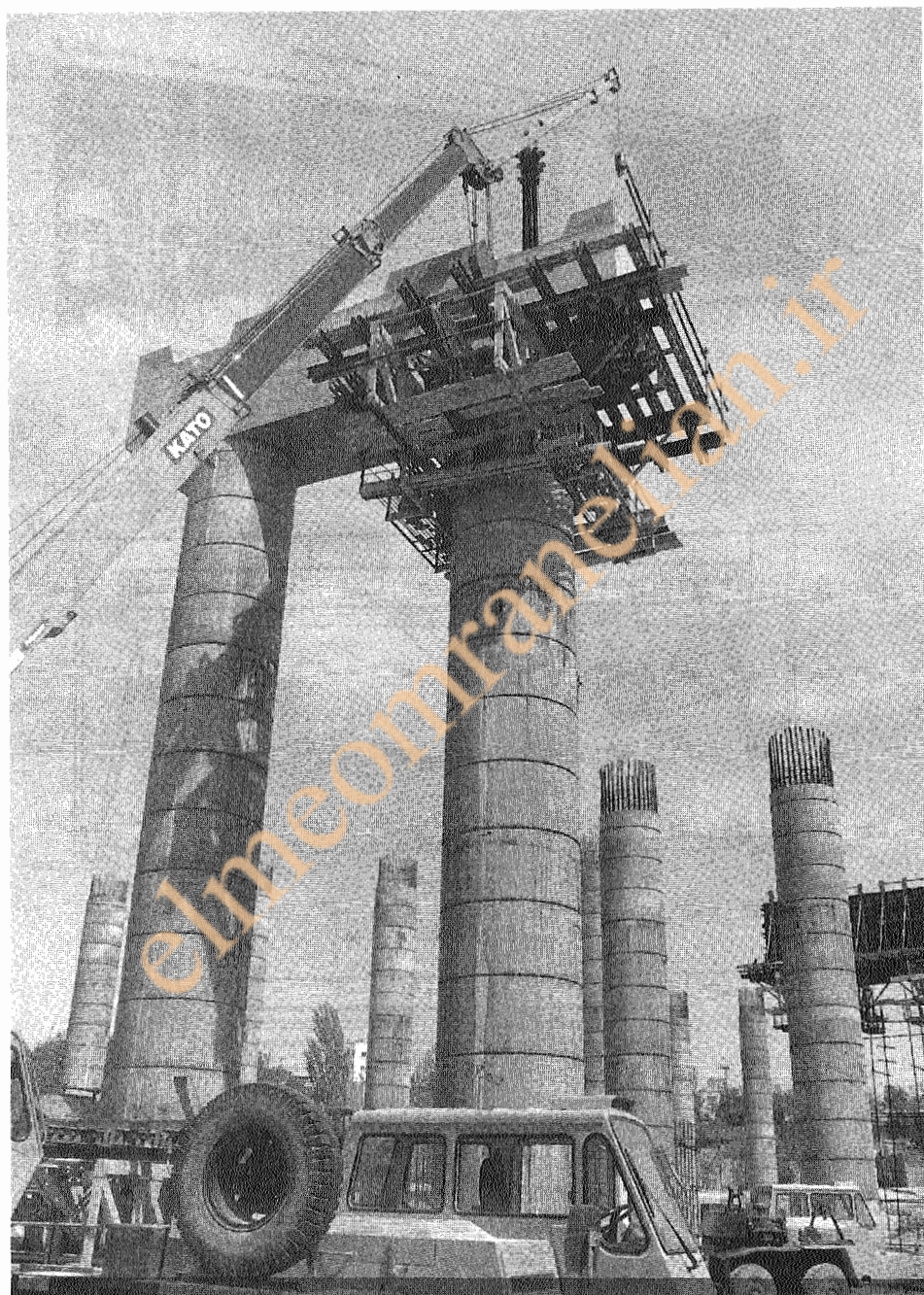
شکل ۱۱-۲ قالب خودایستای تیر سرستون.
