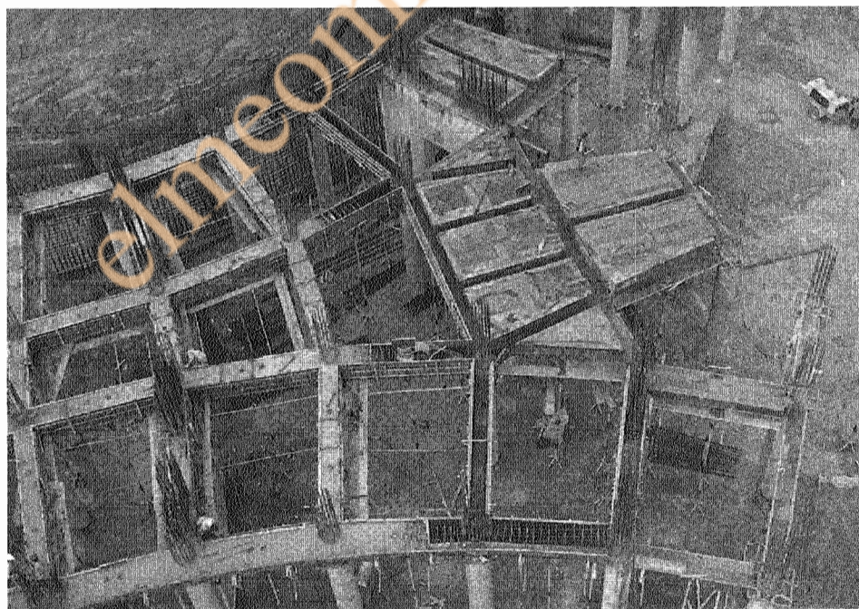
شکل ۸-۱۵ نمای بالای قالب‌بندی تیر
