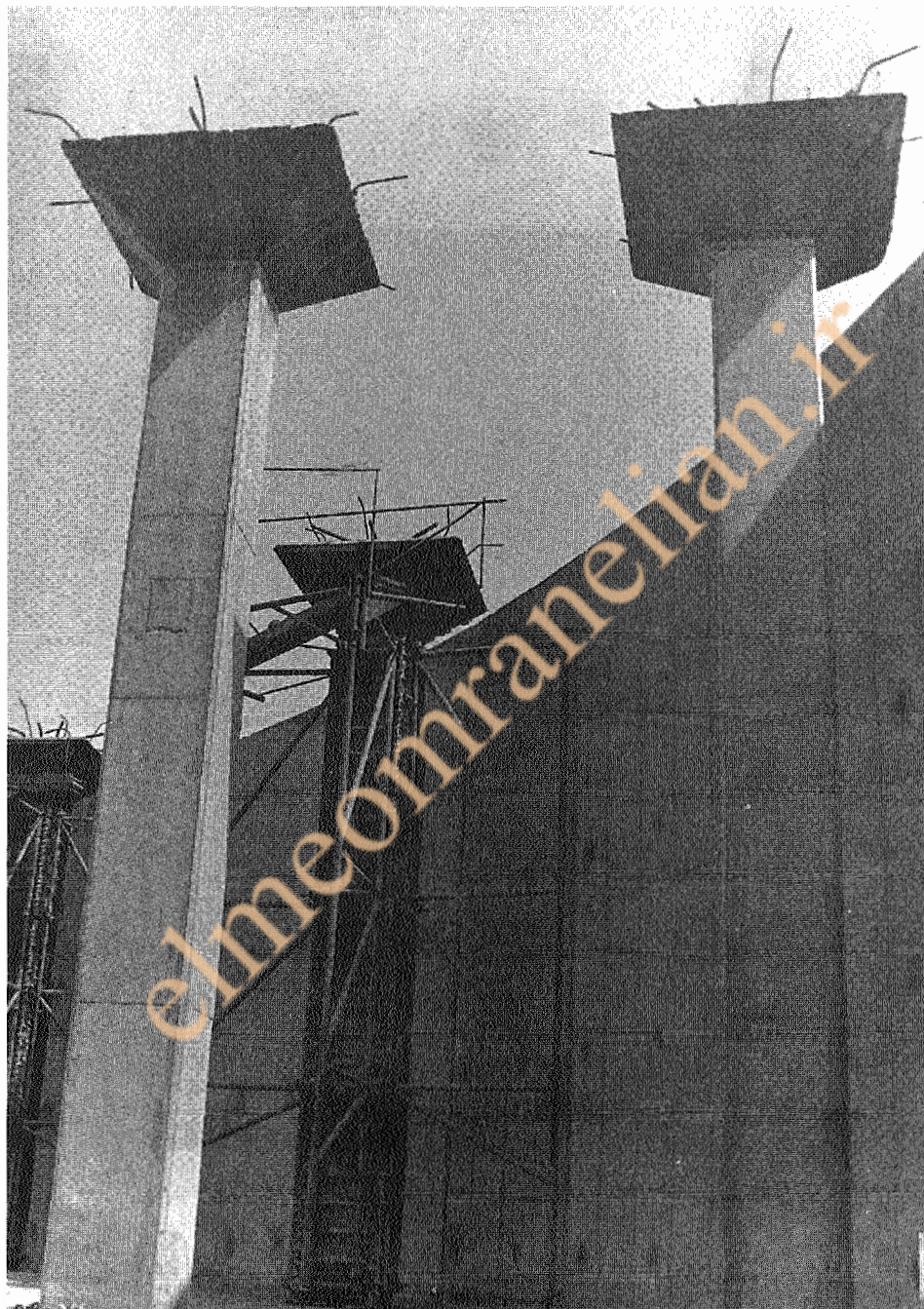
(الف) قالب ستون با سرستون
