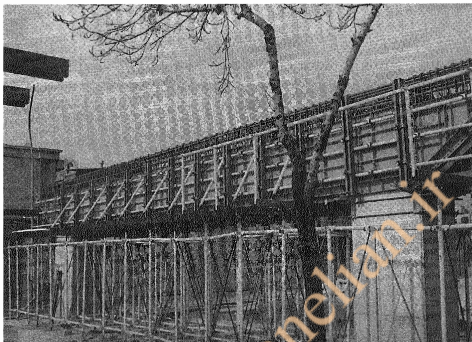
شکل ۸-۹ داربست‌بندی واقعی در زیر تیر سنگین
