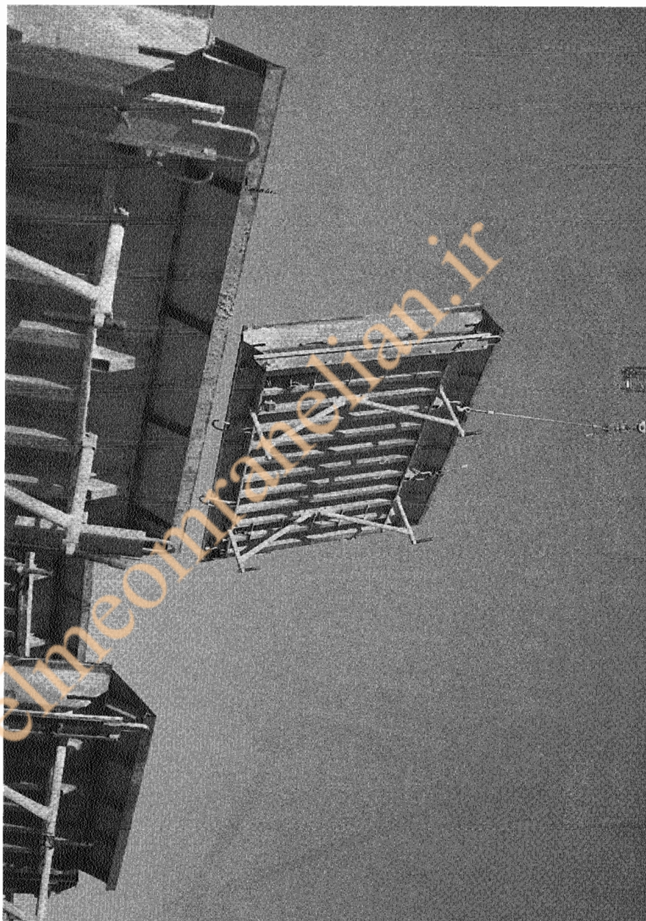
شکل ۶-۹ (ادامه) قالب یکپارچه دیوار در حال پرواز دادن (الف)
