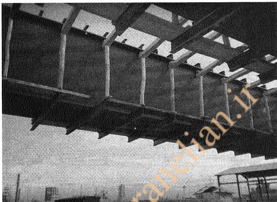
شکل ۱۱-۶ استفاده از دستک‌های چوبی برای اتکای قالب عرشه در تیرهای فولادی جعبه‌ای.
