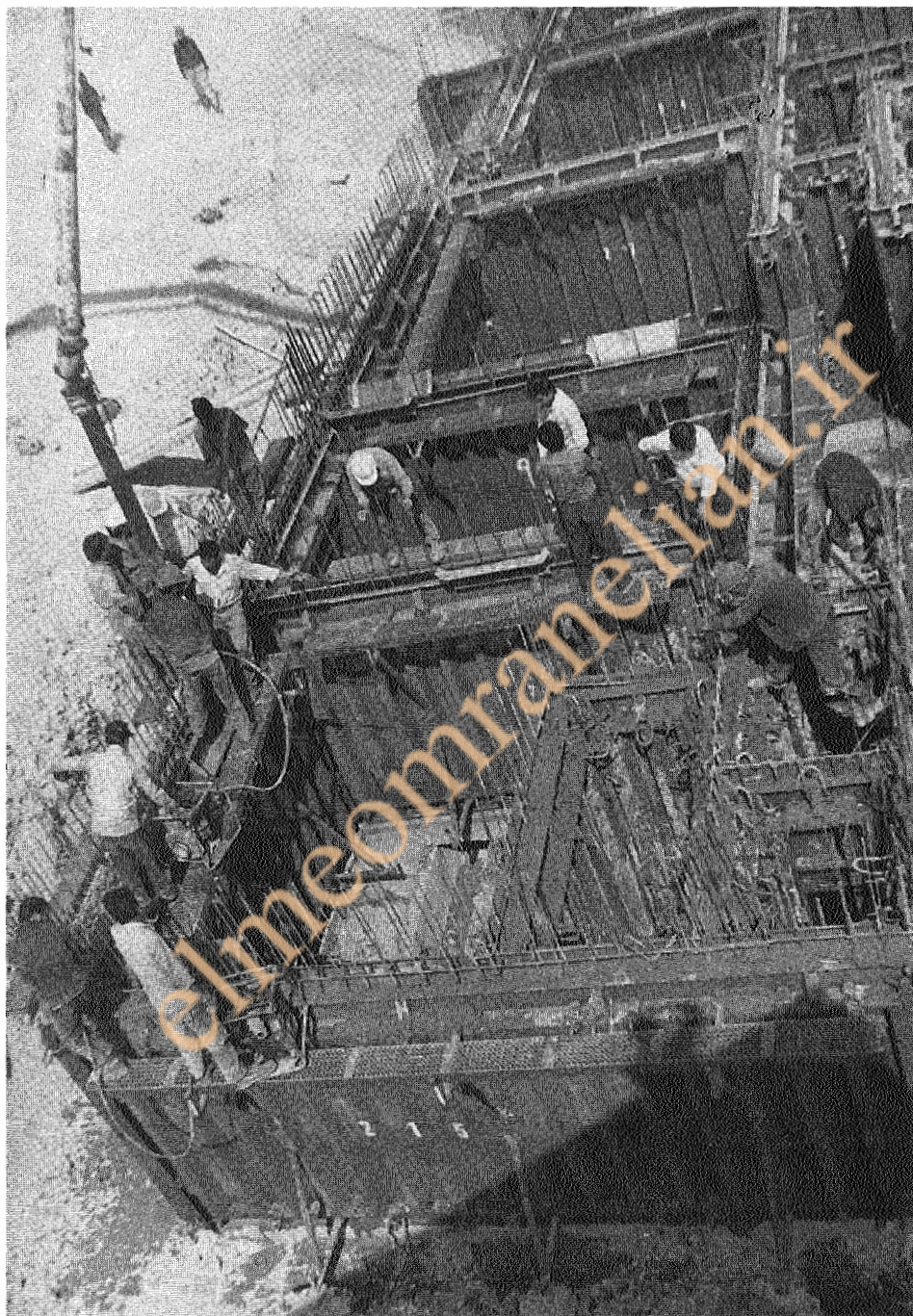
شکل ۶-۹ (ادامه) قالب یکپارچه دیوار در حال بتن‌ریزی
