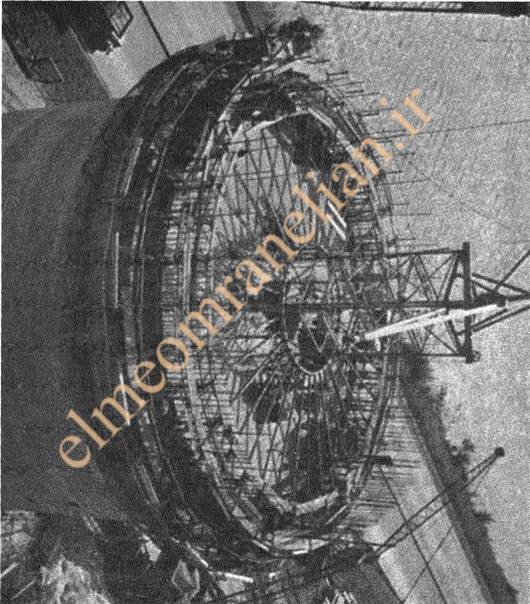
شکل ۱-۱۰ سیلو در حال اجرا توسط قالب لغزنده.
