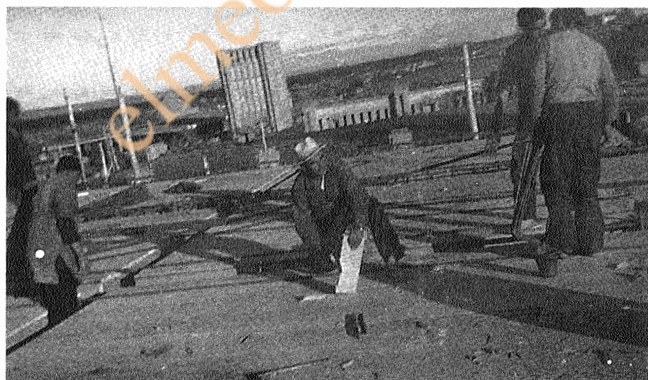
شکل ۱-۲ قالب بندی سنتی با چوب.
