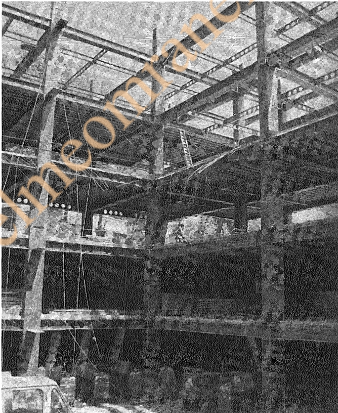
شکل ۸-۳ (ت) قالب سقف کامپوزیت در سازه‌های فولادی
