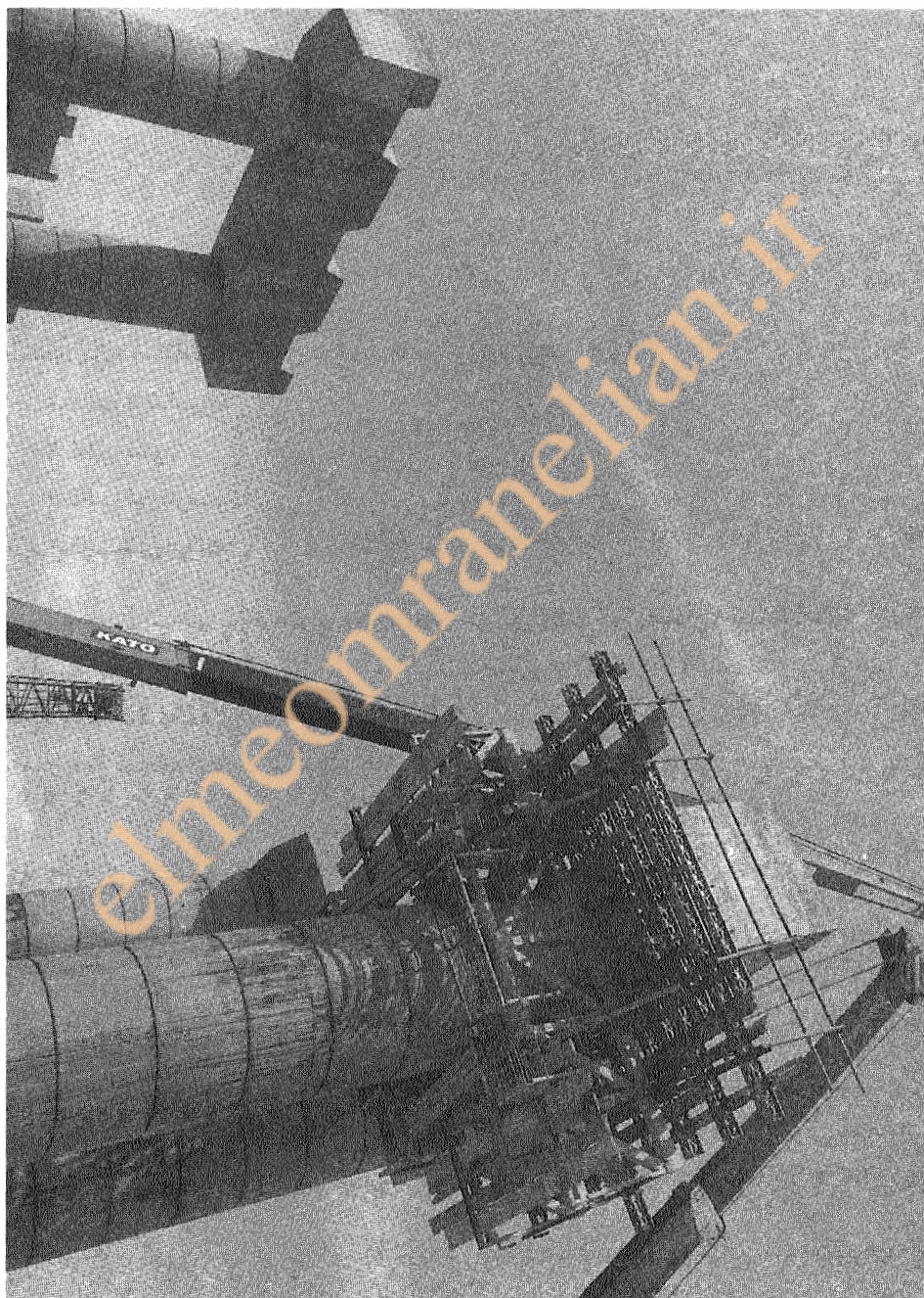
شکل ۱-۱۱ قالب بالارونده ستون در اجرای پایه‌های بلند پل.
