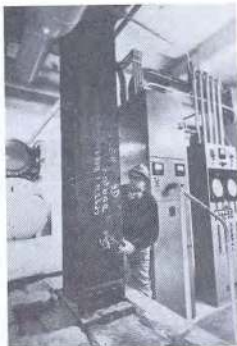
ستون فولادی با کف ستون جوشی و یچی
