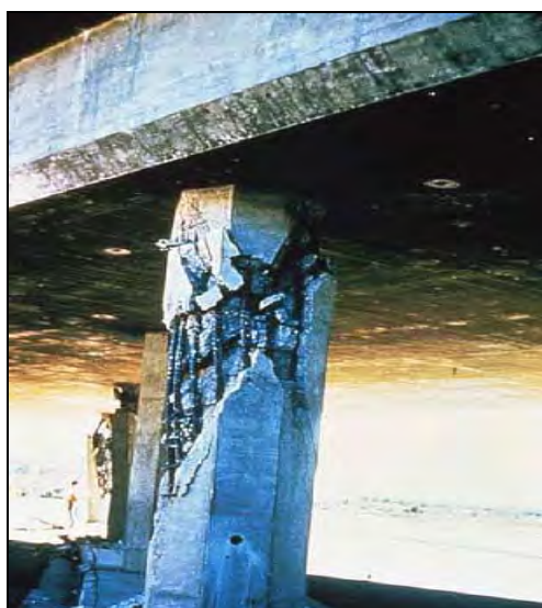
شکل ۲-۵-۱- نمونه‌ای از شکست برشی ستون
