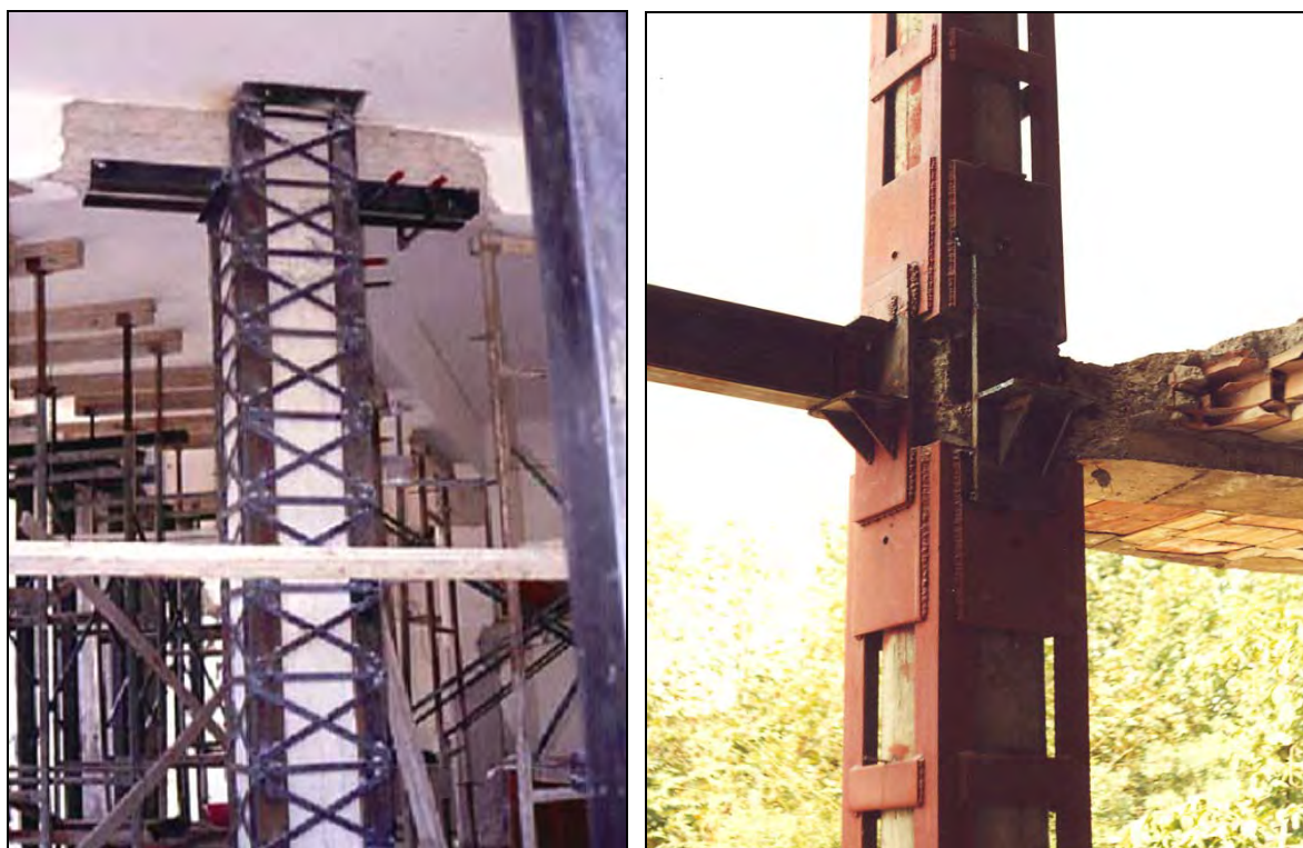
شکل ۲-۶-۲ روش‌های بهسازی اتصالات میانی
