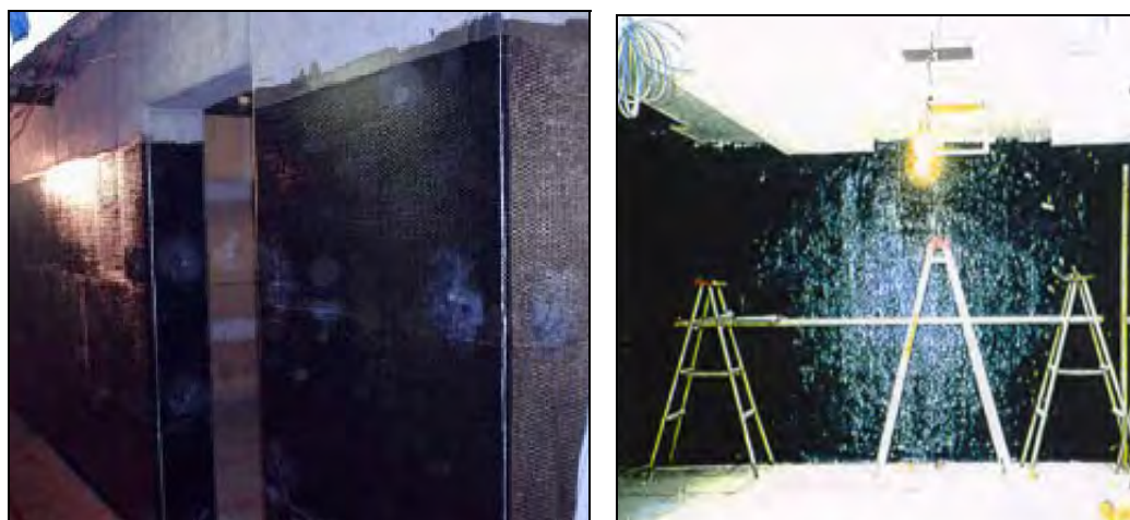
شکل ۴-۴۲- تقویت کلی دیوارهای برشی بوسیله مصالح FRP
