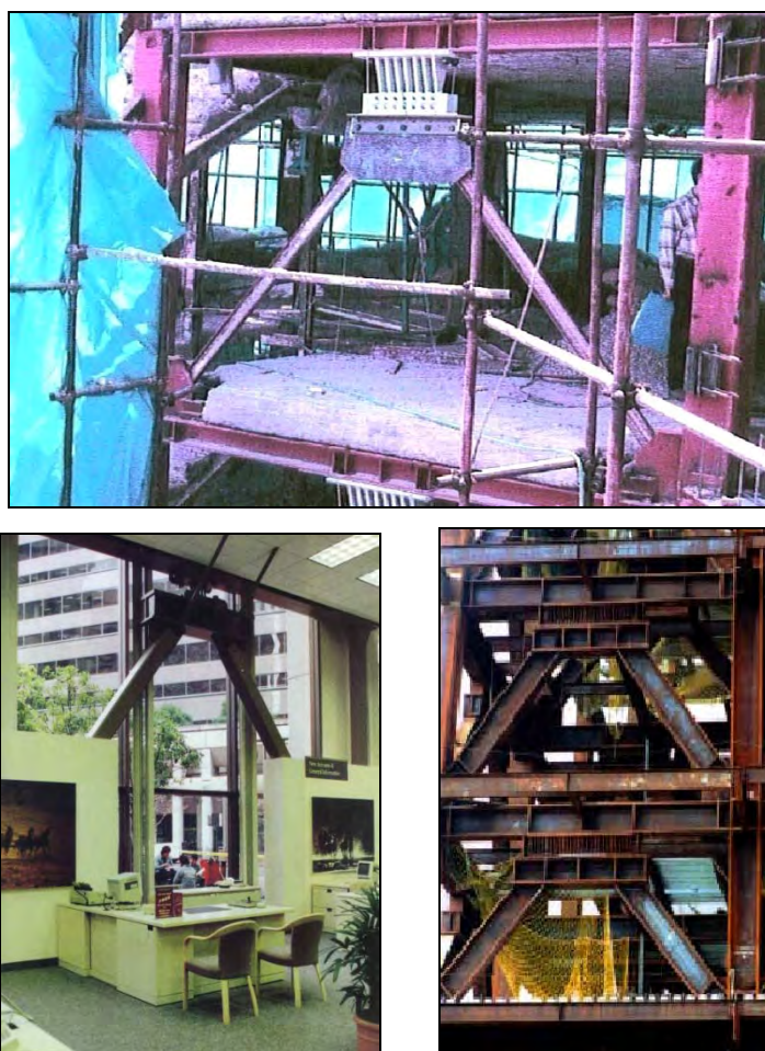
شکل ۷-۱۳- نمونه هایی از بکارگیری میراگر T-ADAS
