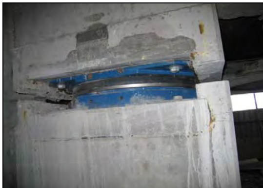
شکل ۶-۱۱- جداگرهای اصطکاکی FPS
