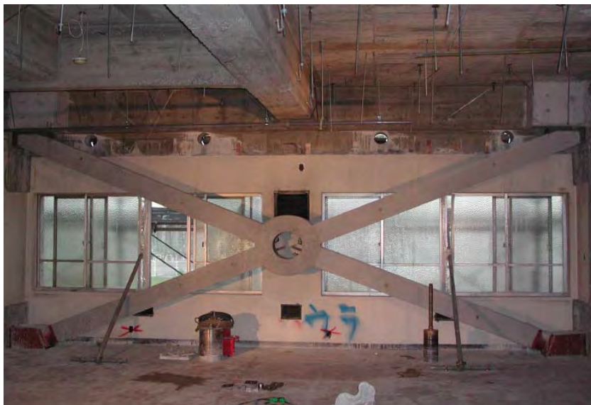
شکل ۴-۲۳ - نمونه‌ای از مهاربند بتنی پیش تنیده و پیش ساخته
