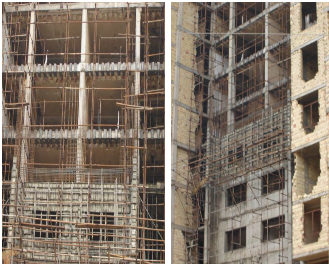
شکل ۴-۴۷ - افزودن میانقاب بتنی به عنوان دیوار برشی
