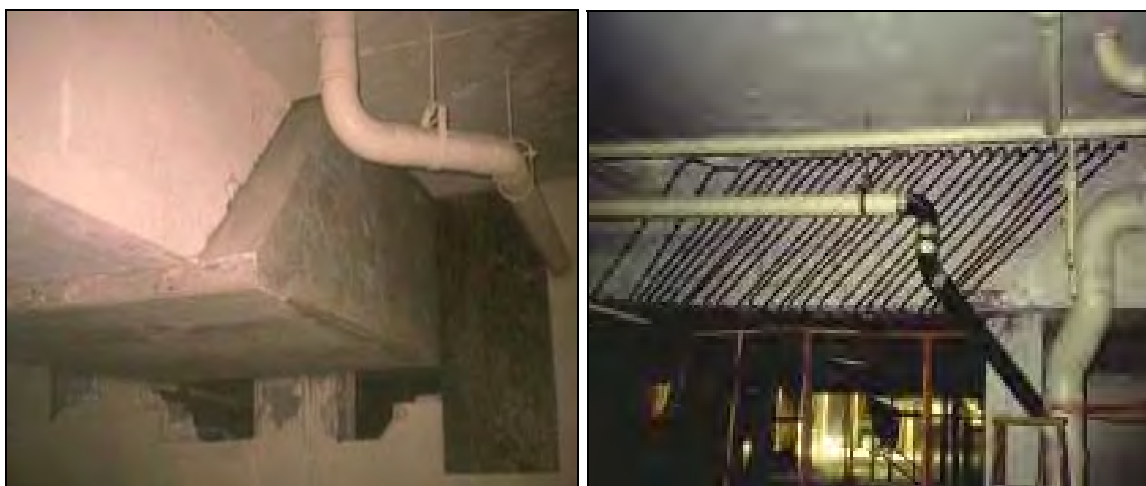
شکل ۲-۴-۴- استفاده از روکش بتنی در مقاوم‌سازی تیرها
