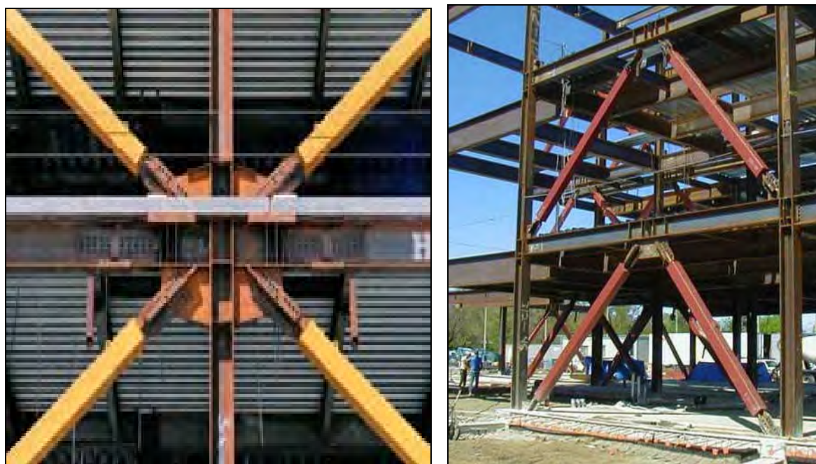
شکل ۴-۱۹- نمونه‌هایی از مه‌اربند ضد کمانش BRBF
