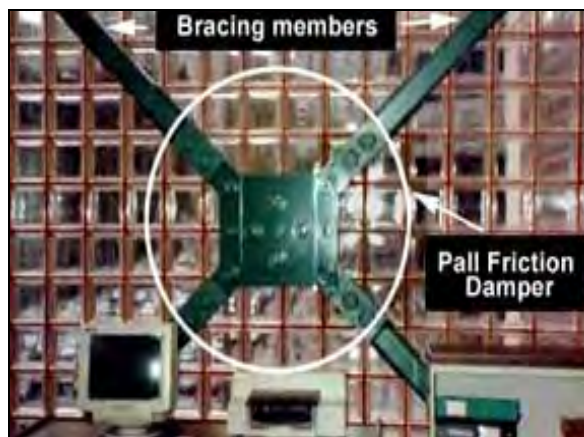
ادامه شکل ۷-۶- استفاده از میراگرهای اصطکاکی پال (Pall) در مقاوم سازی
