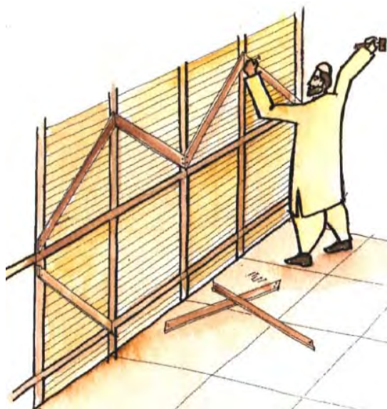
شکل ۹-۳۸ پیوستگی اعضای قطری
