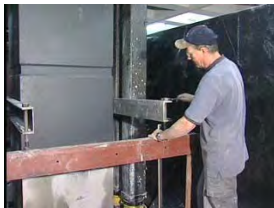
شکل ۶-۱۸ - نصب سازه خرپایی نگهدارنده
