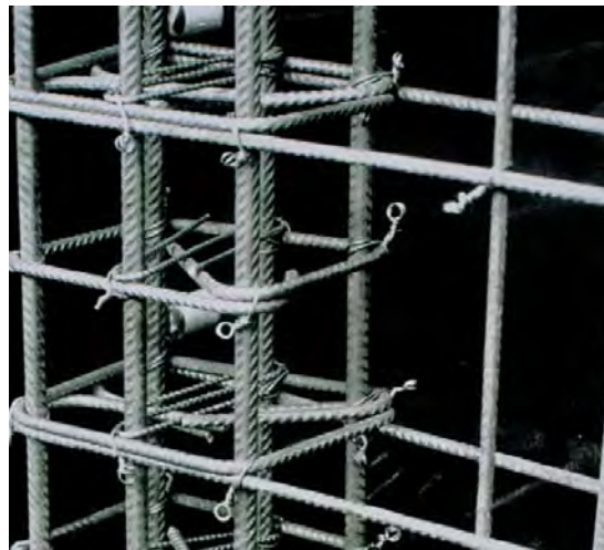
شکل ۳-۱۶- اجرای جزئیات مناسب و شکل‌پذیر در ستون‌ها
