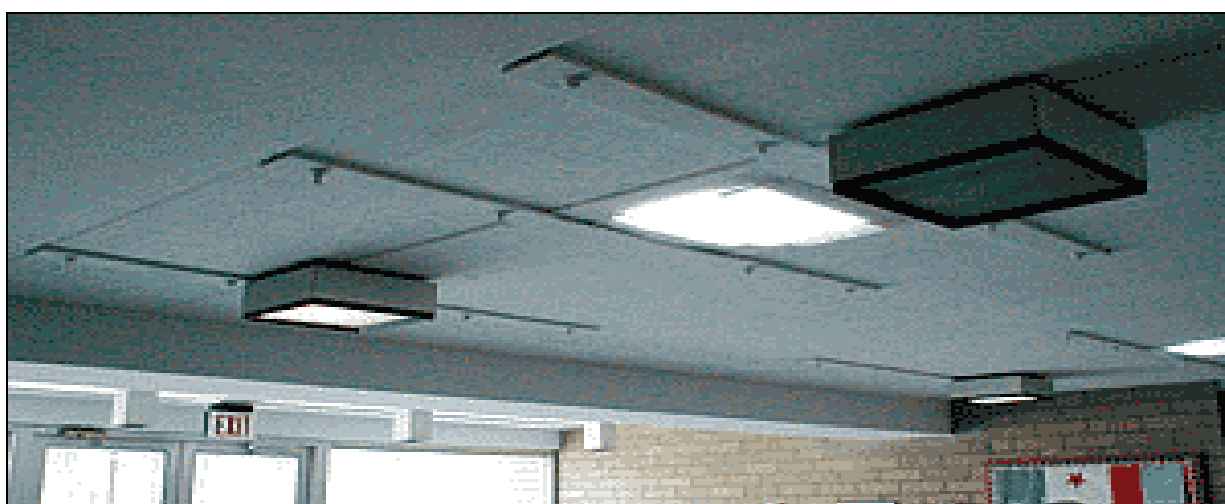
شکل ۲-۳-۷- تقویت دال‌ها با استفاده از ورق‌های فولادی
