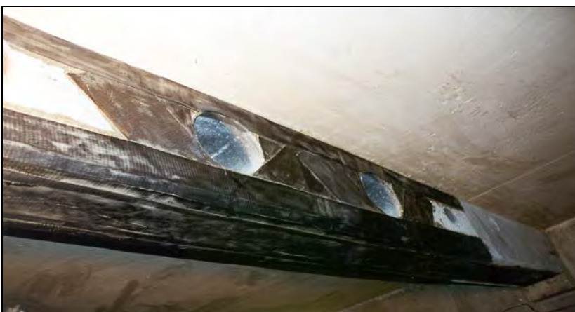
شکل ۲-۴-۱۵- تقویت موضعی سوارخ‌ها در تیر FRP
