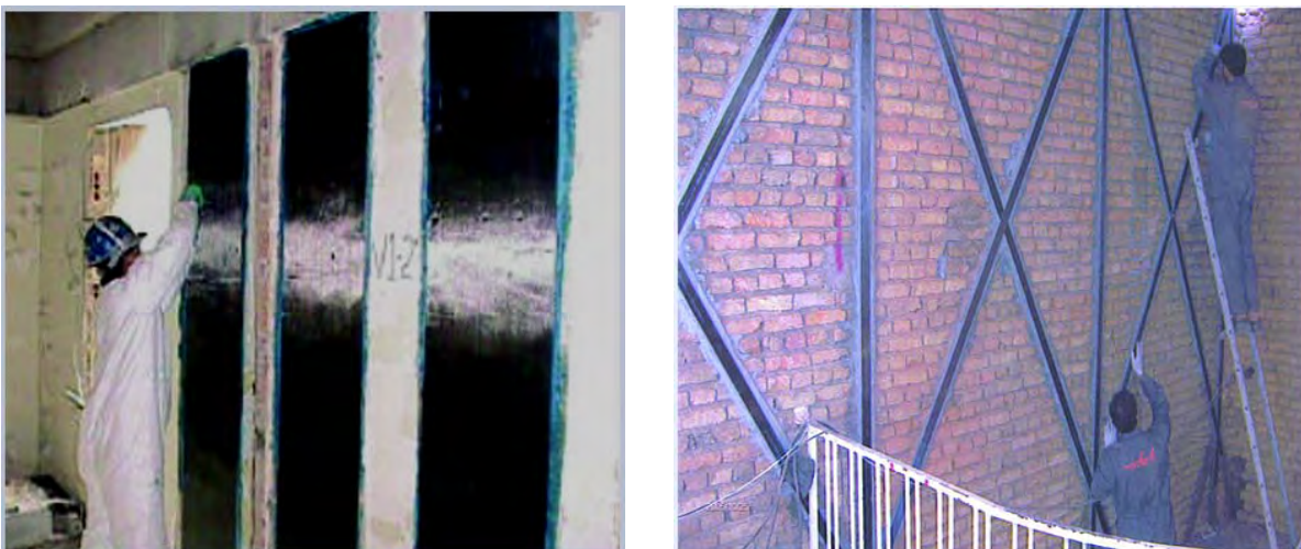
شکل ۸-۱۹ - نحوه اجرا و نصب نوارهای FRP
