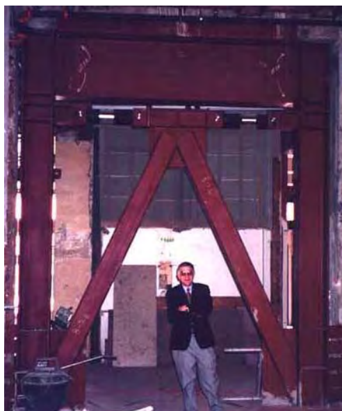
شکل ۷-۱۸- استفاده از میراگرهای ویسکوز در بادبندهای جناقی
