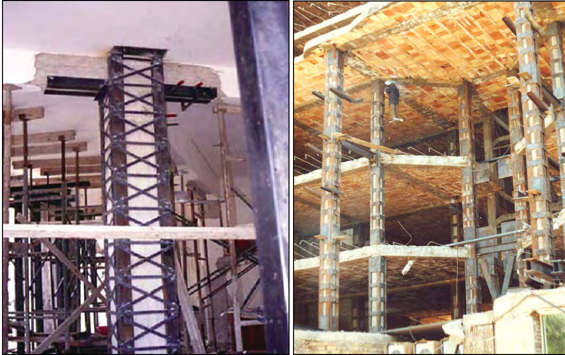
شکل ۲-۵-۱۳- بهسازی ستونهای بتنی بوسیله روکش فولادی قفسه‌ای
