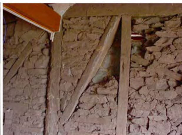
پ: ریزش تکه‌هایی از مواد پرکننده
