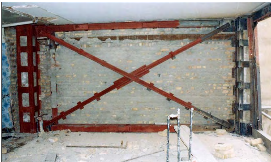
شکل ۴-۵- بهسازی قاب‌های موجود بوسیله مهاربندهای همگرا
