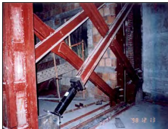
شکل ۷-۱۹- استفاده از میراگرهای ویسکوز در بادبندهای قطری
