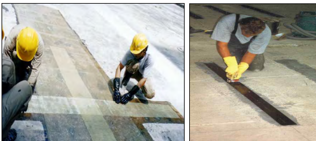
شکل ۱۱-۳-۲- مقاوم‌سازی دال در لنگرهای منفی بوسیله FRP
