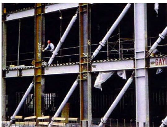
شکل ۷-۱۹- استفاده از میراگرهای ویسکوز در بادبندهای قطری
