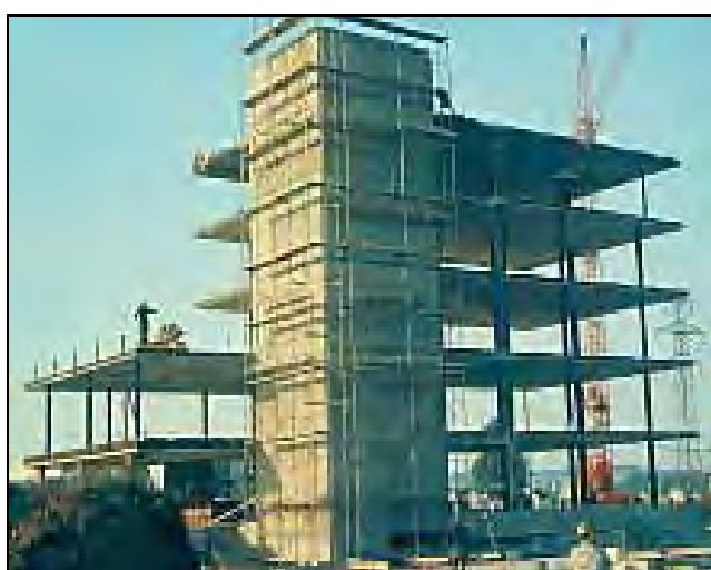
شکل ۳-۶- فاصله زیاد بین مرکز جرم و مرکز سختی و خرابی ناشی از ایجاد پیش‌سختی
