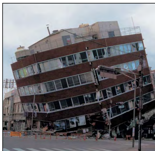
شکل ۳-۶- فاصله زیاد بین مرکز جرم و مرکز سختی و خرابی ناشی از ایجاد پیش‌سختی
