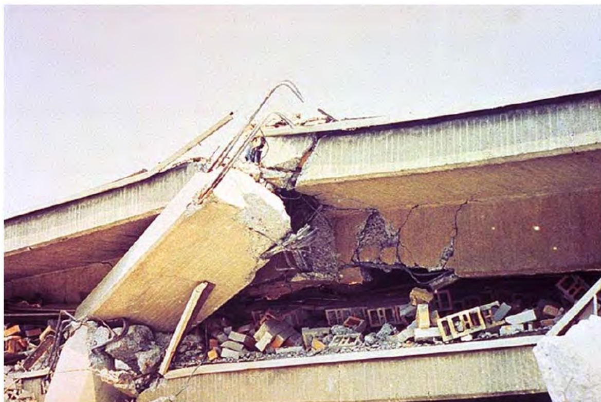
شکل ۲-۶-۱۰ وجود درز سرد در محل اتصال
