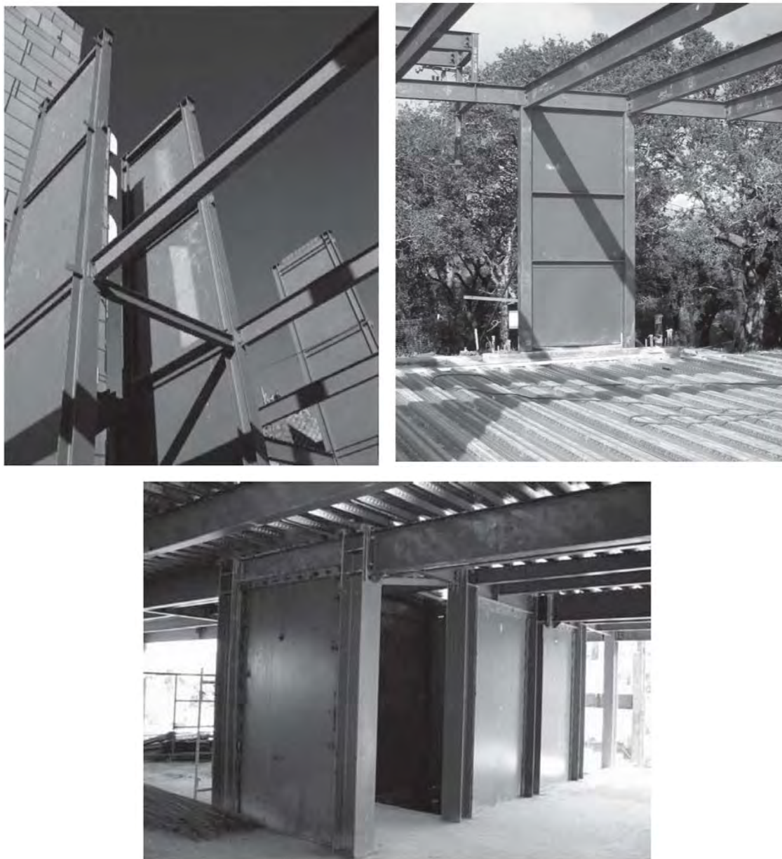
شکل ۴-۵۰- دیوار برشی فلزی
