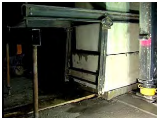
شکل ۶-۱۹ - خروج بلوک بریده شده
