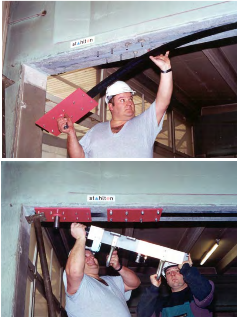
شکل ۲-۴-۱۷- روش پیش‌تنیدگی در صفحه FRP
