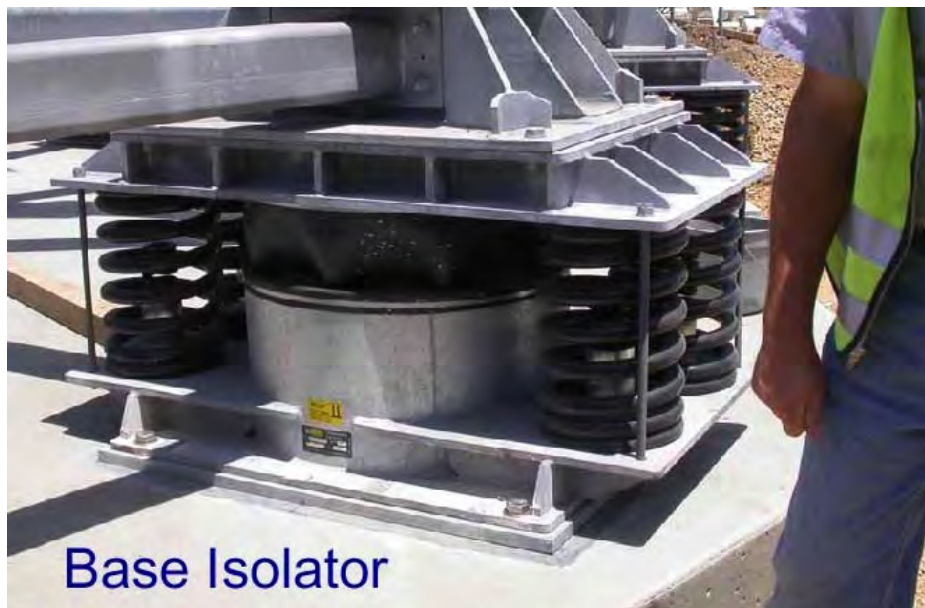
شکل ۶-۱۲- جداگر GERB
