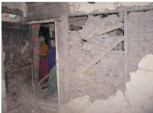
پ: ریزش تکه‌هایی از مواد پرکننده
