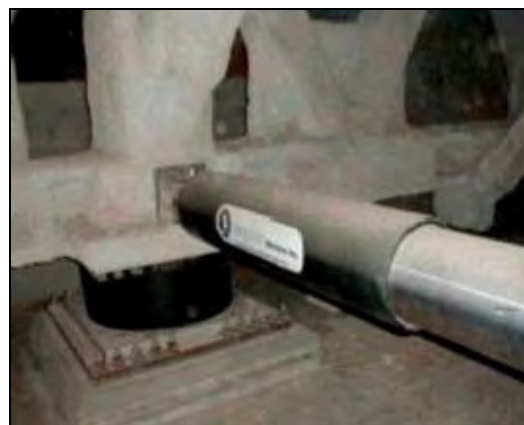
شکل ۷-۱۶- جزئیات تیپ سیستم میراگر ویسکوز
